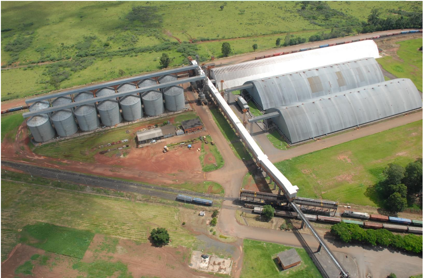
Foto: Terminal Graneleiro de Sumaré.
